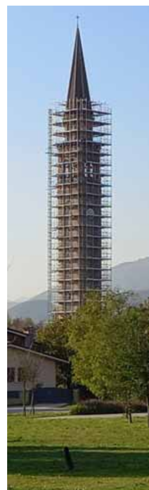
Ponteggi sul campanile di Sernaglia
